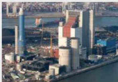
石炭火力プラント
